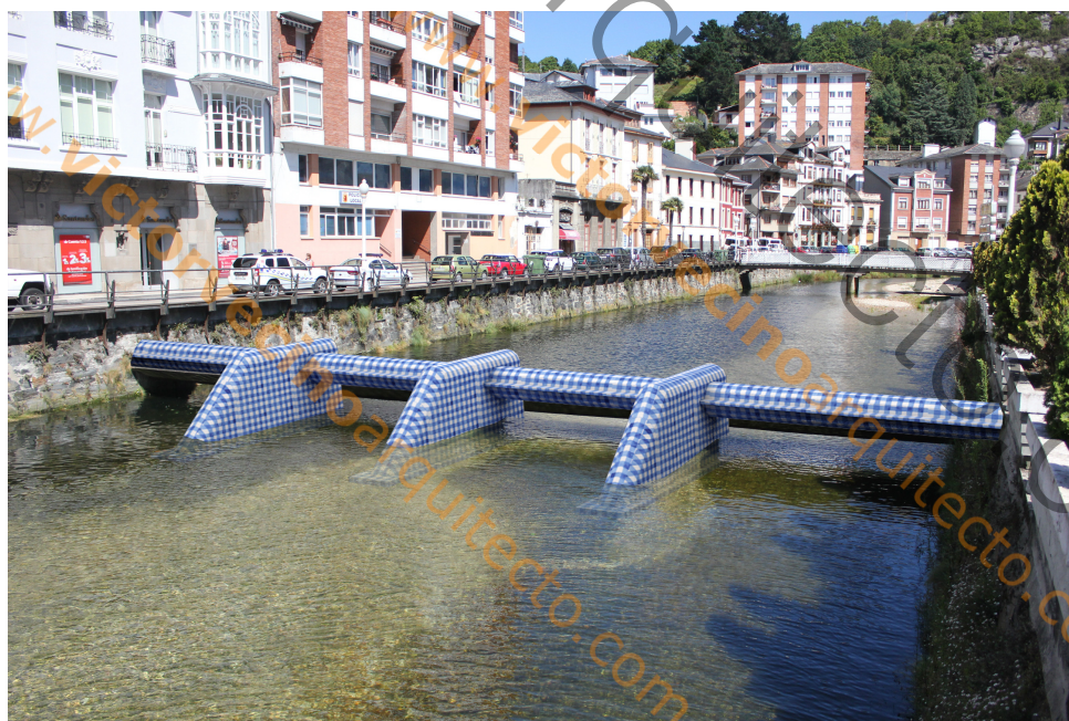
INTERVENCIÓN CHAMBRÓN EN TUBERÍA A SU PASO POR EL RÍO
